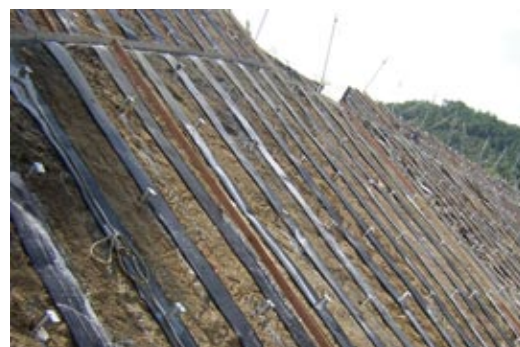
法面での施工例
