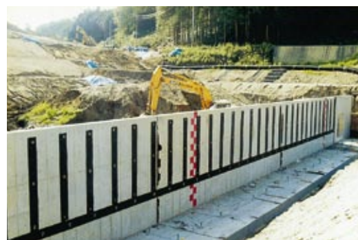
擁壁での施工例
